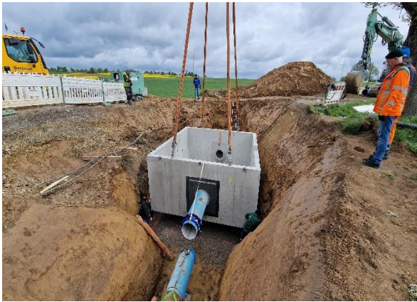
Neubau Transportleitung Hildrizhausen
