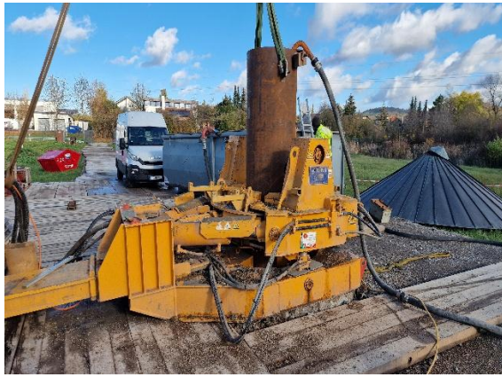
Sanierung Brunnen Poltringen 2
