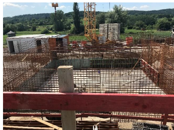
Neubau Rohwasserbehälter im Wasserwerk
