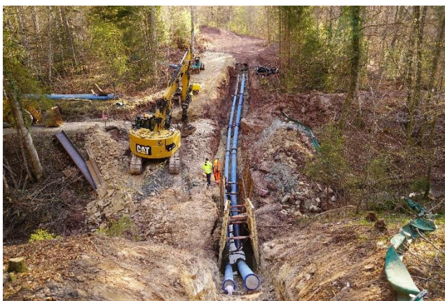
Erneuerung der Ochsenbachquerung
