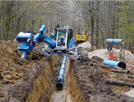
Neubau Transportleitung Dettenhausen-Süd mit symbolischer Inbetriebnahme
