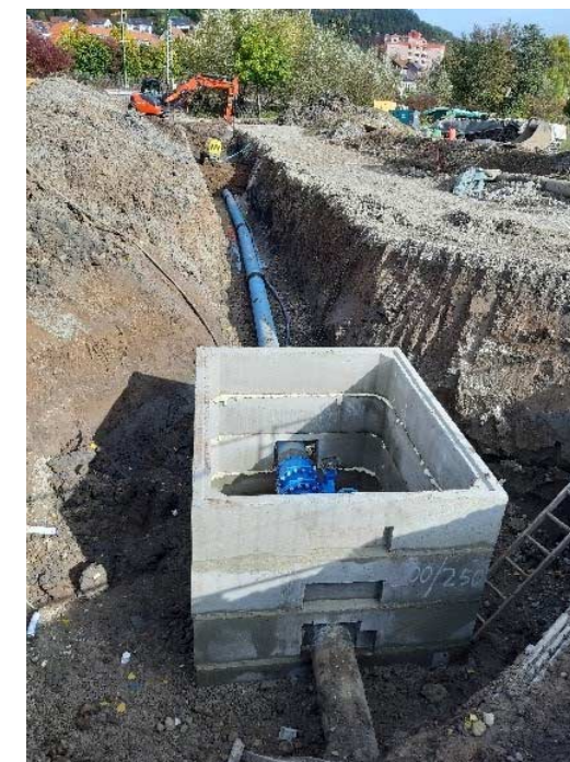
Bahn- und Ammerquerung Unterjesingen
