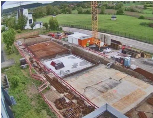
Neubau Rohwasserbehälter Wasserwerk Poltringen
