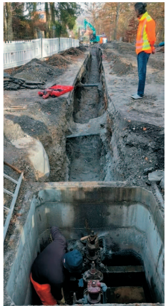
Sanierung FL Waldenbuch – Weiler Berg
