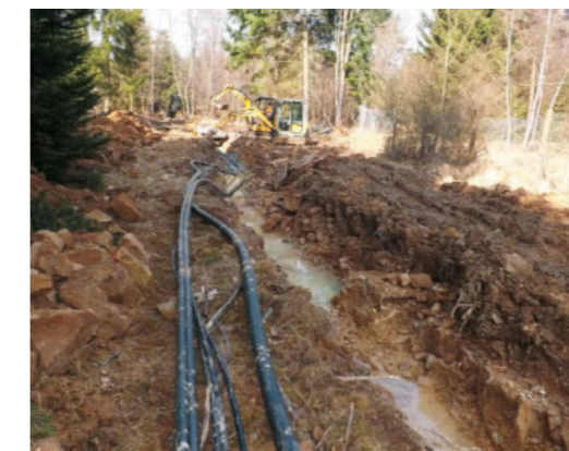
Erneuerung des 1,3 km langen Stromkabels zwischen den Behältern Hochzone und Niederzone Bromberg
