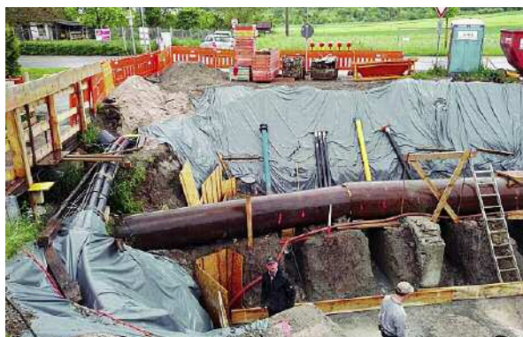
Bau eines Dükers im Poltringer Weg in Ammerbuch-Entringen.
